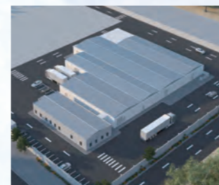
▲竣工予定のエジプト工場
