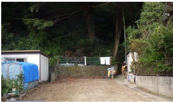
支障木及び工事用進入路
