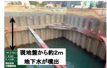
現地盤から約2mから砂礫層となる。透水係数が高く地下水位の高さまで掘削後すぐに冠水する。(橋梁下部工の施工状況)
