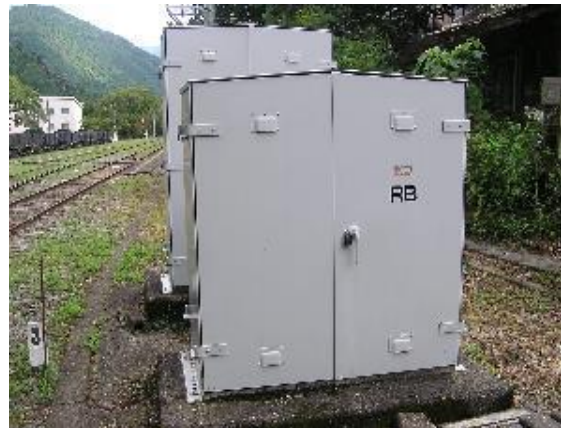
信号制御リレー取替
