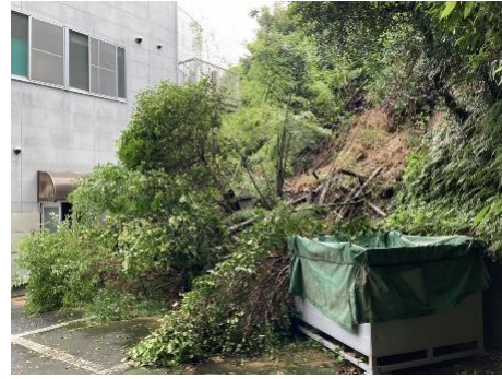
がけ崩れの状況 (湖西市鷺津)
