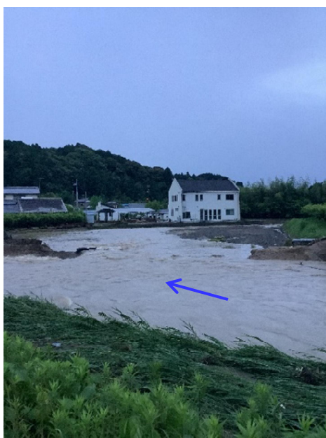
二級河川敷地川の破堤 (磐田市敷地)
