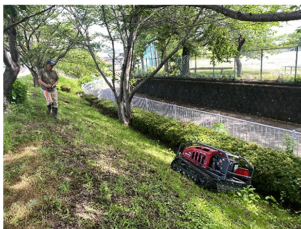
リモコン式草刈機による堤防除草状況
