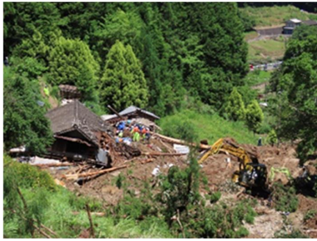
土石流の状況 (浜松市天竜区引佐町)
