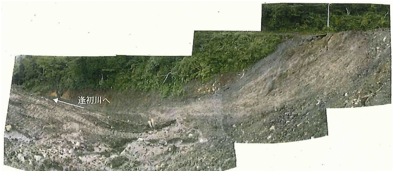
【逢初川源頭部の状況】
