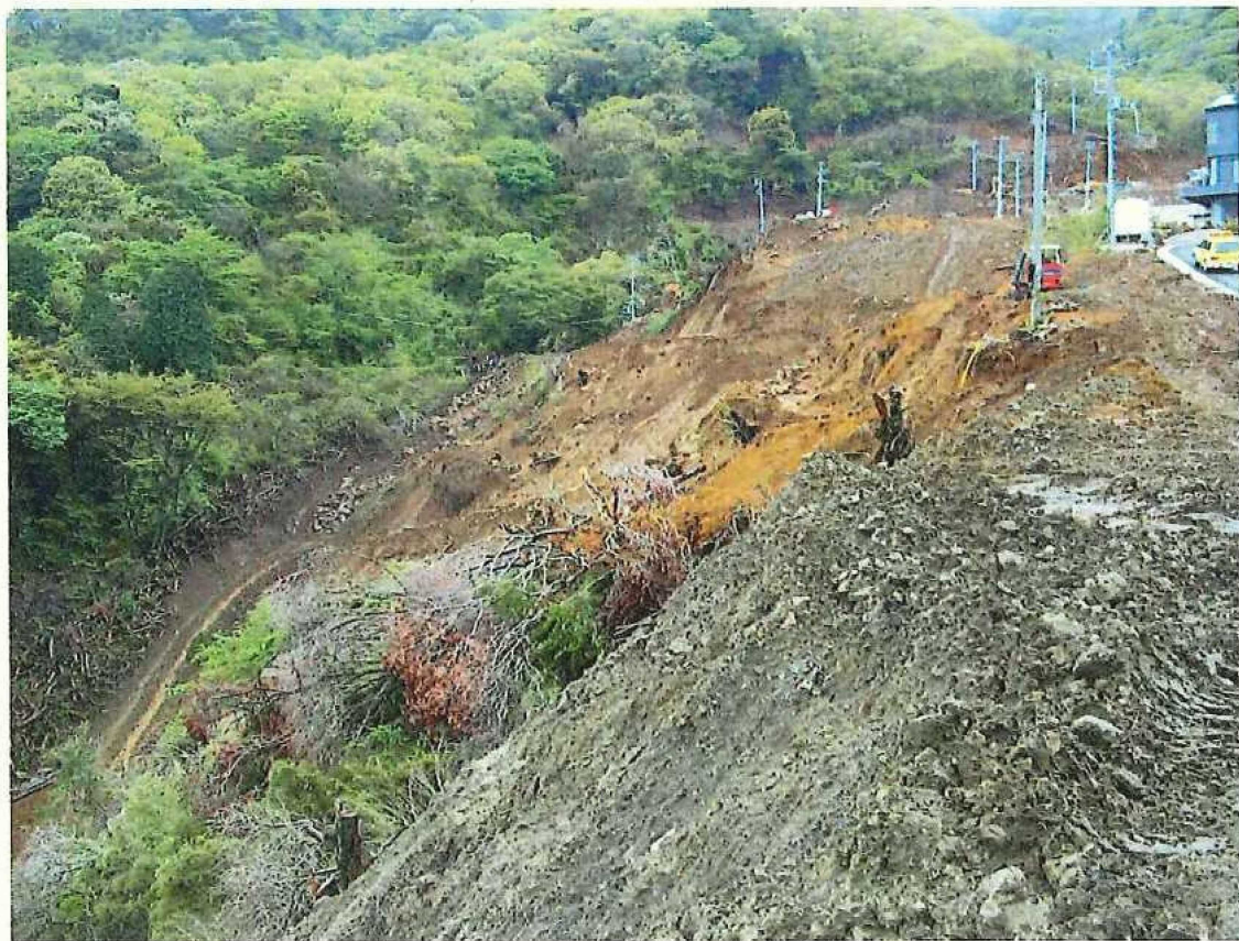
【逢初川源頭部の状況】
