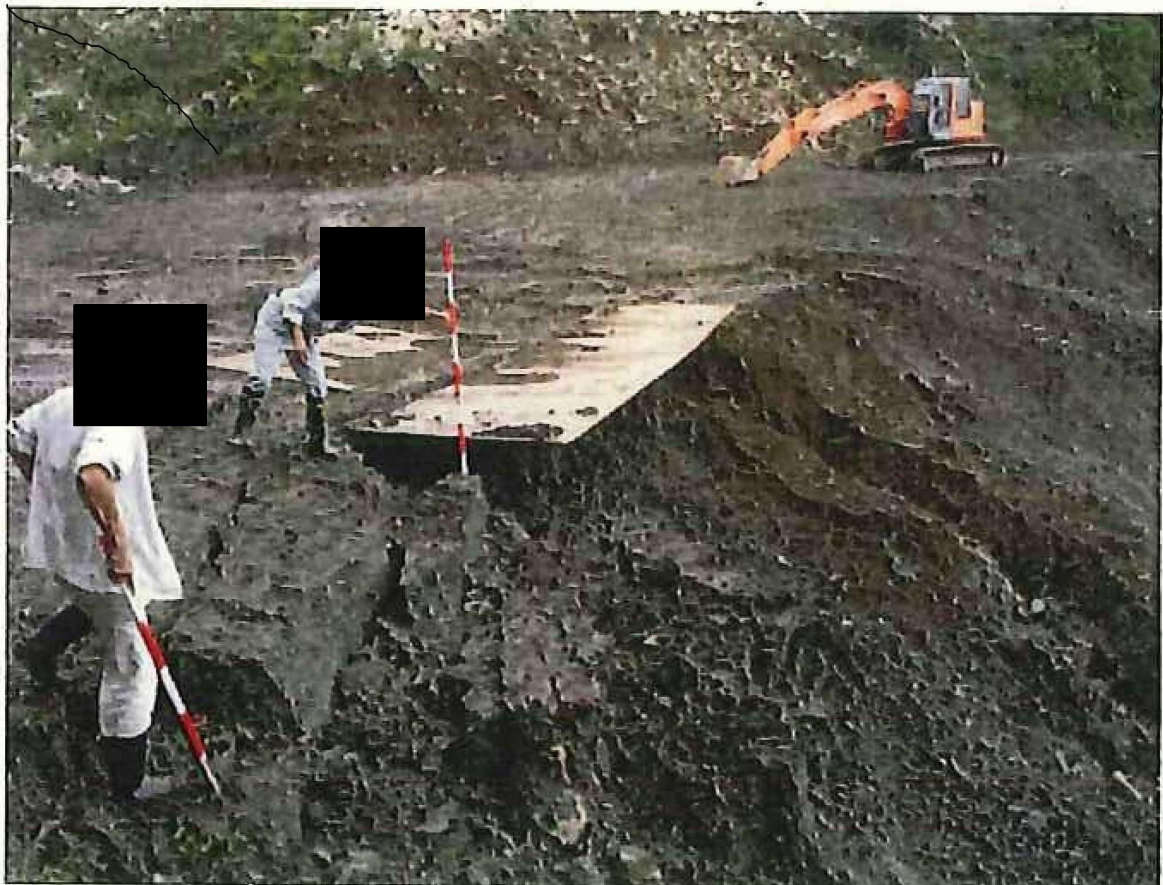
【逢初川源頭部の状況】
