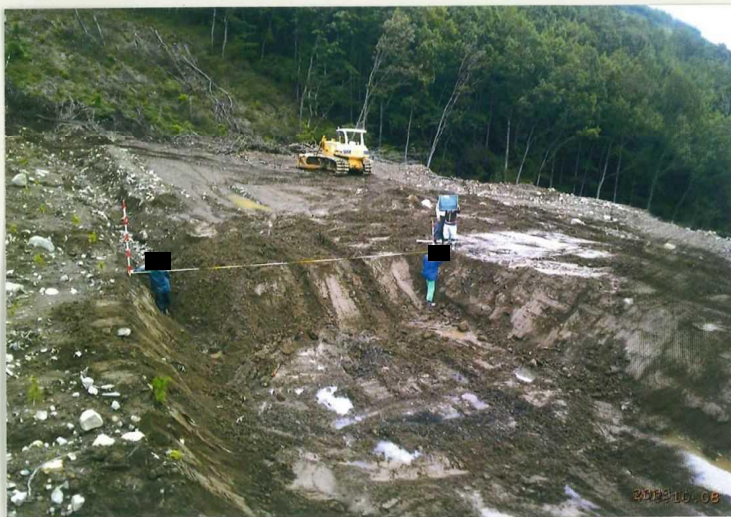
④区域・D工区の防災工事完了届に添付されていた仮設沈砂池の写真 【 2008 (H20) 年10月15日 撮影 】 (D116)
