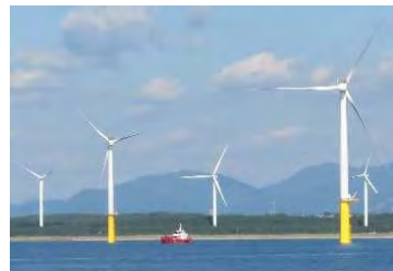
秋田港内における洋上風力発電の様子
