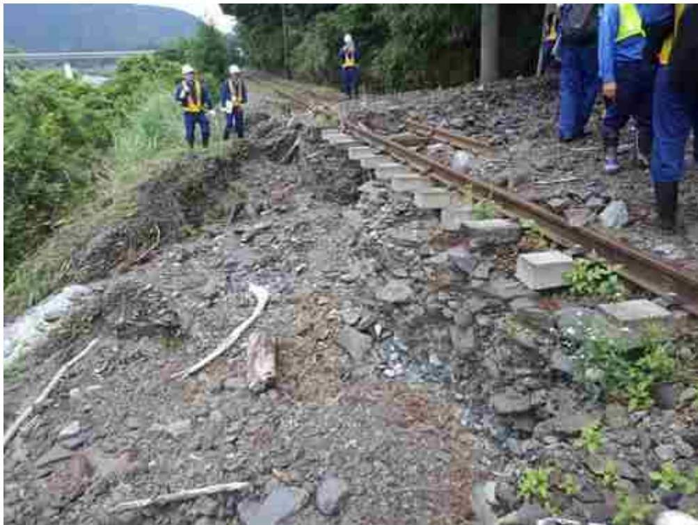
暗渠で排水しきれなくなった水及び土砂により道床が洗掘
