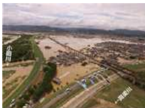
[小田川における浸水被害(岡山県倉敷市)]
