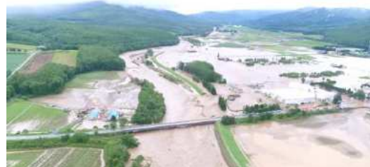
[空知川における浸水被害(富良野市)]
