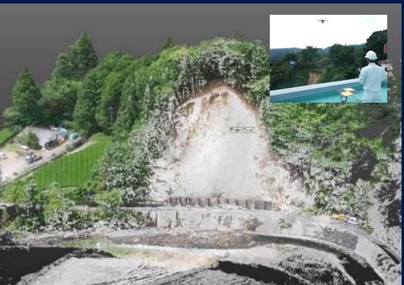
被災後に3次元点群データ計測
