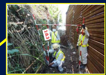
被災範囲抽出と形状寸法計測
