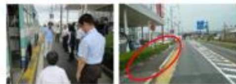
▲現地調査の様子
