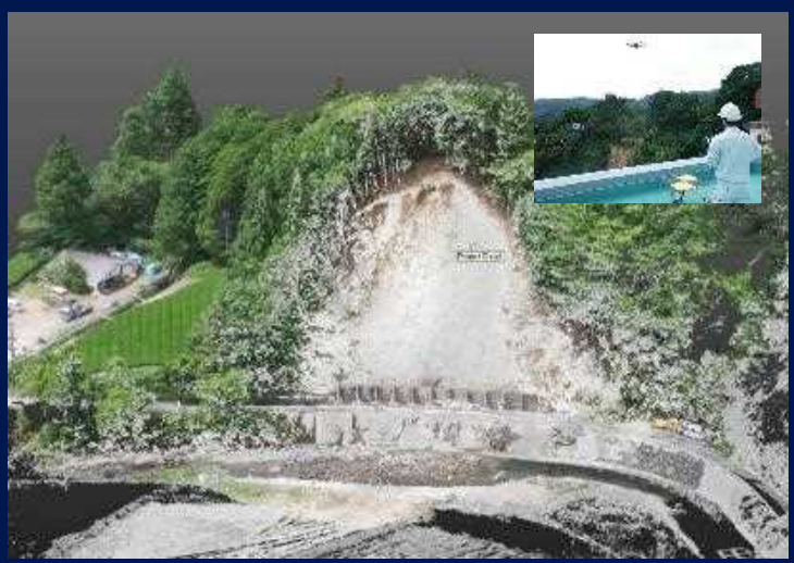
被災後に3次元点群データ計測
