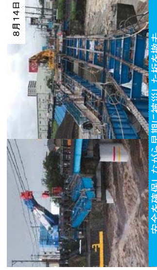
橋脚洗掘対策として袋詰め玉石設置
