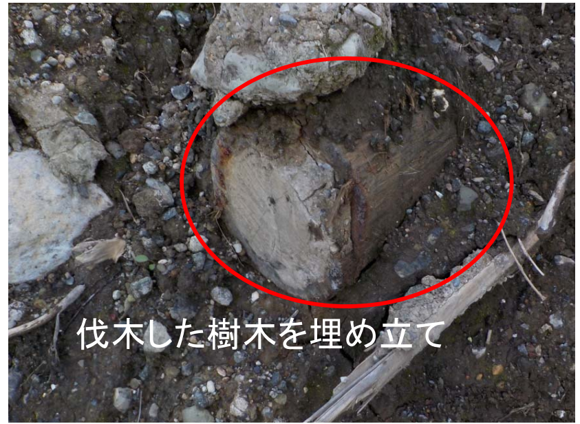
電柱や立木をそのまま埋めている。通常は除根の必要があるが、伐木のみで埋められている。電柱も、根入れと思われる部分が設置時点のまま残っている。
