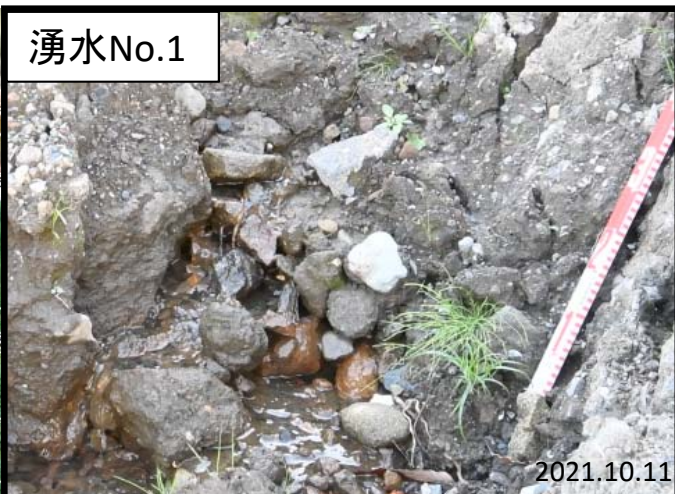
湧水No.1 崩土と地山の境界 地山は茶色粘土層の土壌
