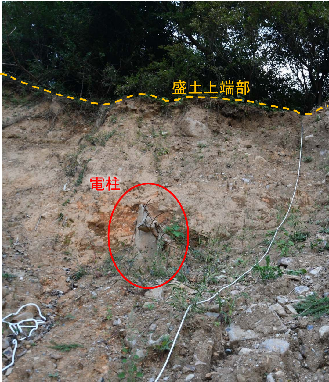
電柱や立木をそのまま埋めている。通常は除根の必要があるが、伐木のみで埋められている。電柱も、根入れと思われる部分が設置時点のまま残っている。
