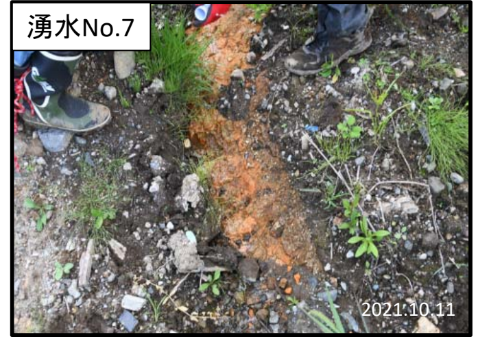
湧水No.7 崩土と地山の境界 湿地上(植生あり)
