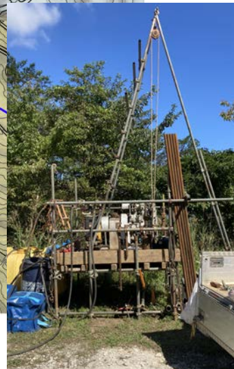
No.1ボーリング実施状況
