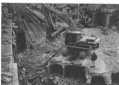
(d) シナリオ D：桁が直角方向へ変位した例
