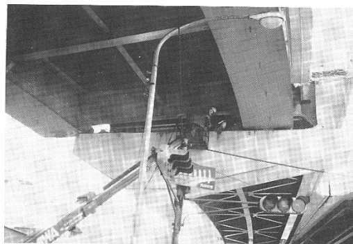
図 8-28 曲線橋の落橋事例（橋軸直角方向への変位）
