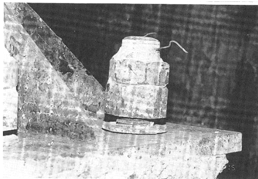
図 8-17 鋼製橋脚アンカー一部の損傷
