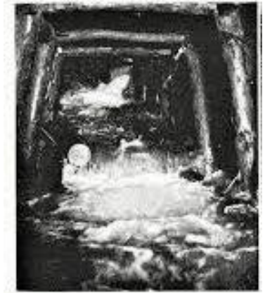
丹那トンネルの湧水状況 出典) 鉄道80年のあゆみ 1872-1952、 運輸調査局(編)、日本国有鉄道
