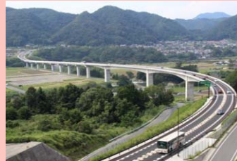
国道414号天城北道路 ＜伊豆市＞
