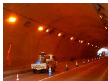
県道塩出尾崎線（尾崎トンネル） ＜富士宮市＞
