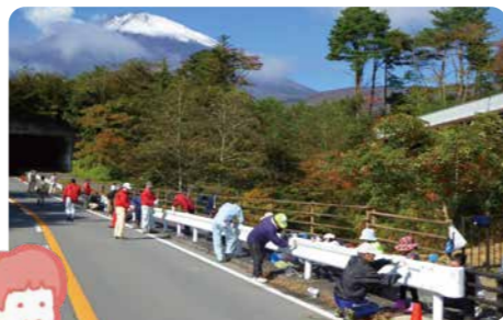
ガードレールを塗り替えている様子
