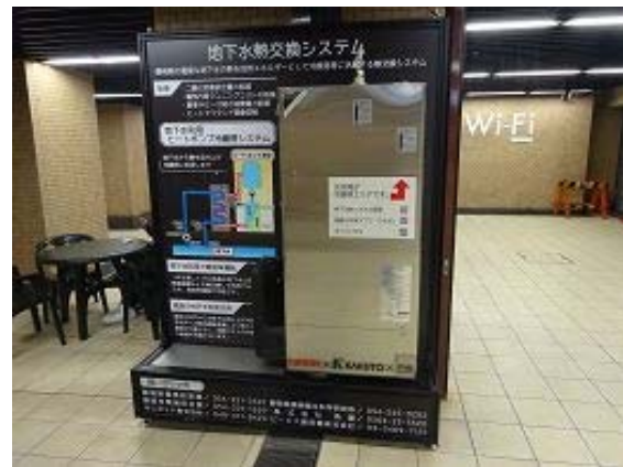
ヒートポンプ側
