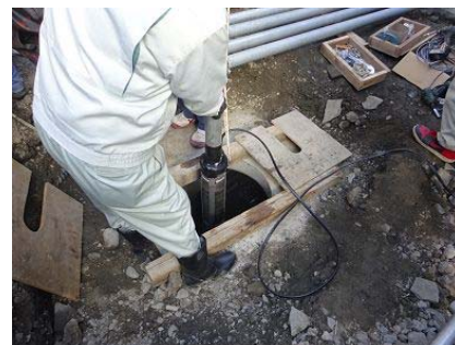
井戸ポンプ設置の様子
