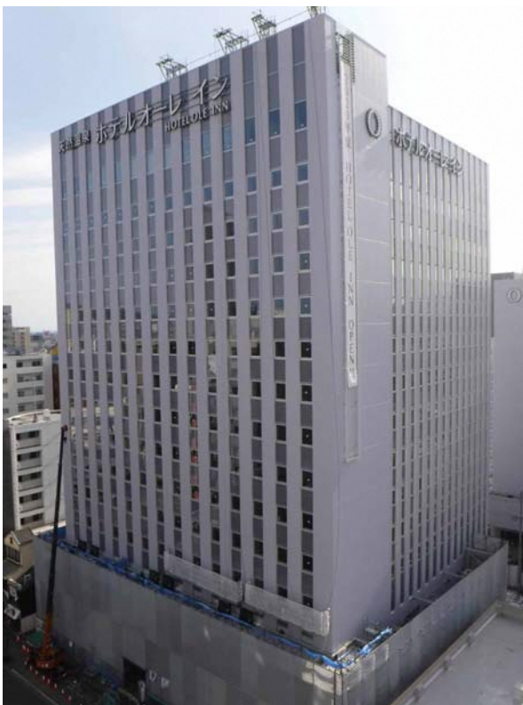
建物外観（2020年2月3日時点）
