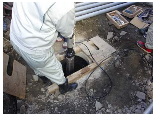
井戸ポンプ設置の様子
