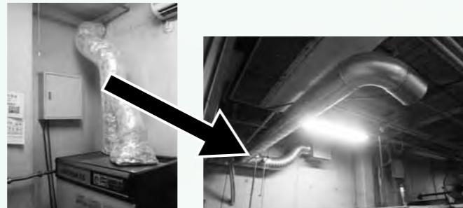
<コンプレッサ室から隣室へ>
