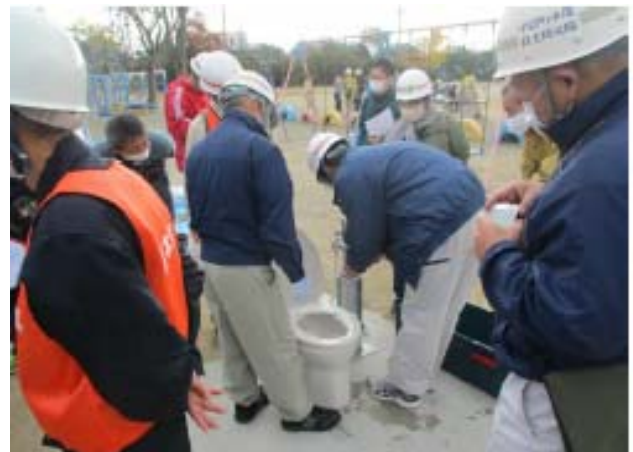
浜松市：マンホールトイレ組立
