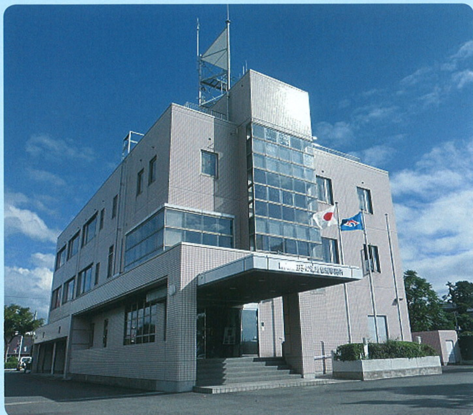
静岡県田子の浦港管理事務所
