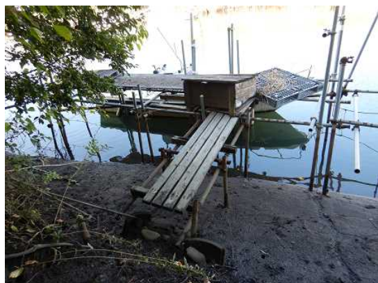
栈橋(鋼管パイプ、渡し板)
