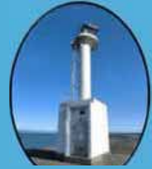
防波堤B灯台
