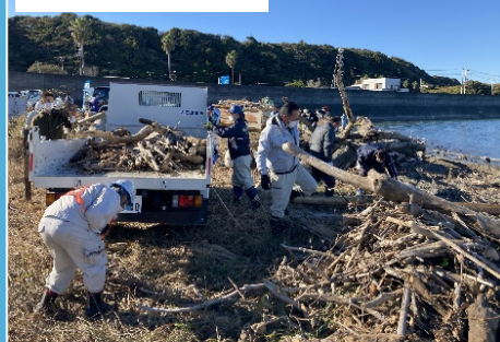
漂着流木の撤去状況
