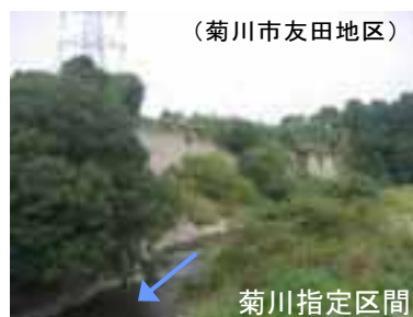
図 1-4 切り立った河岸の状況
